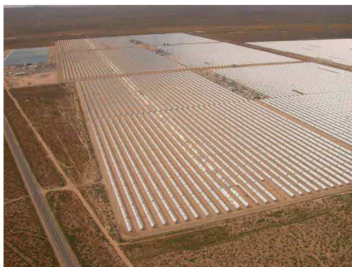
습세계에서 가장 큰 태양광 발전소인 Solar Energy Generating Systems (SEGS). 캘리포니아 남부에 있는 모하비 사막에 위치함. 30)
