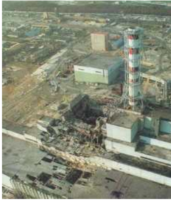
↳지붕이 완전히 파괴되어 내부의 방사성 물질이 그대로 노출되었다.
