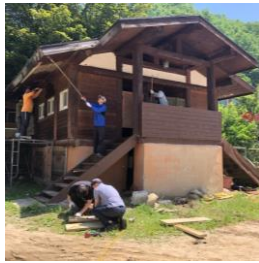
생태 화장실 오일스테인 작업
