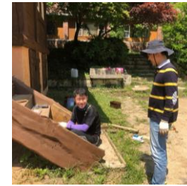
생태 화장실 계단보수
